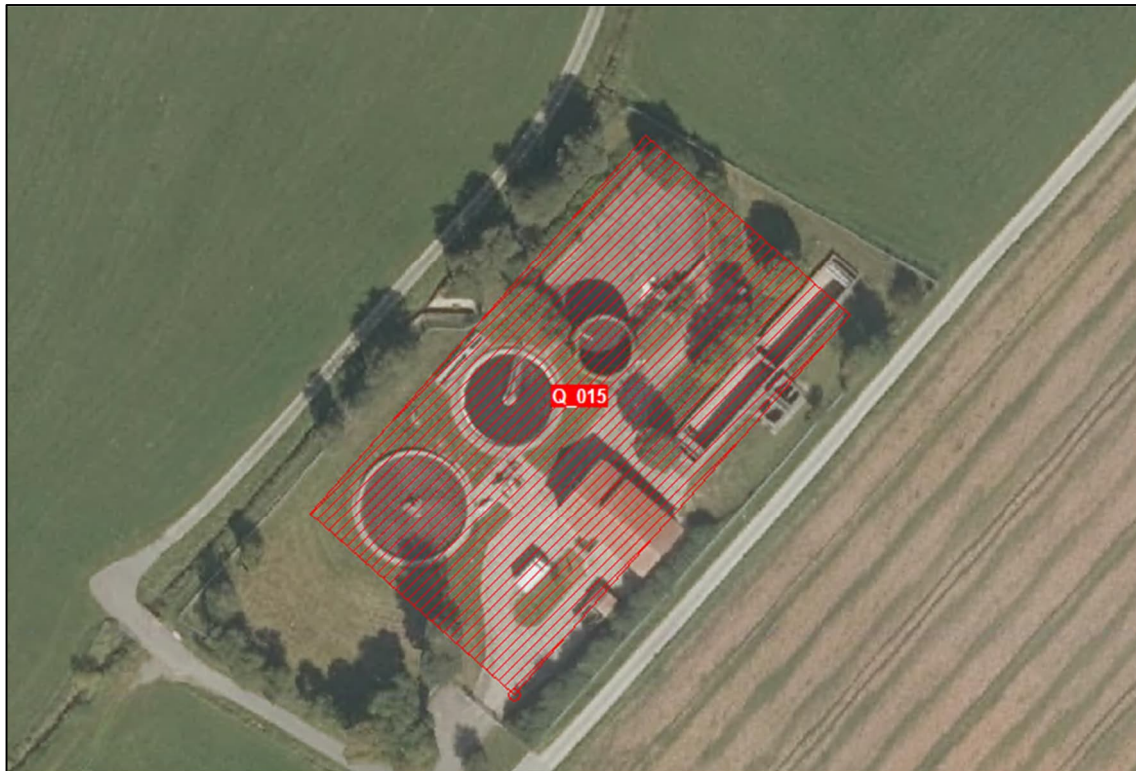
Abbildung 10: Luftbild mit Darstellung der Emissionsquelle (Kläranlage Irchenrieth)
